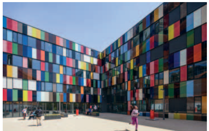
De gevel bestaat uit een bonte mengeling van glazen panelen.
